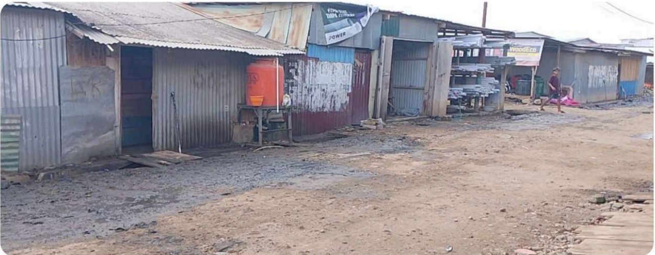
Kondisi Pasar Sebelum dan sesudah dibersihkan
