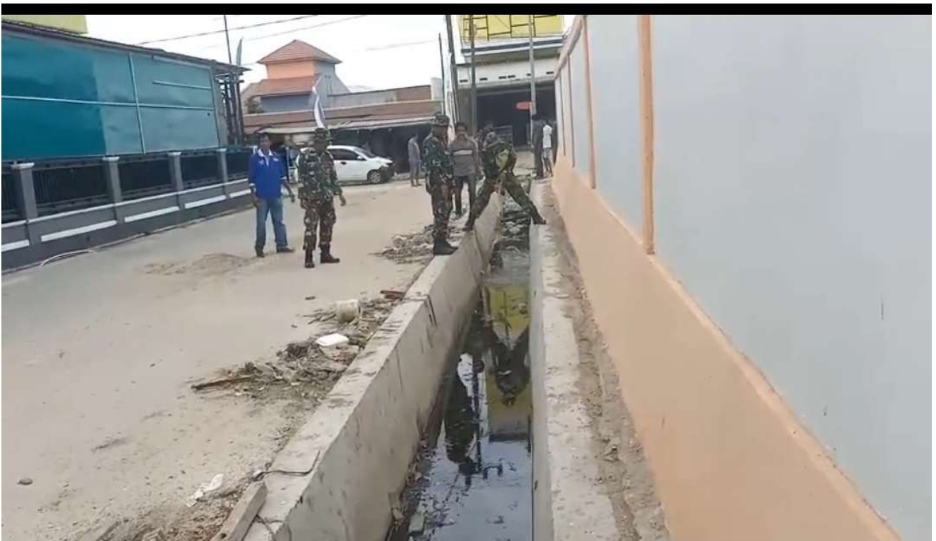
Kondisi Saluran air setelah dibersihkan
