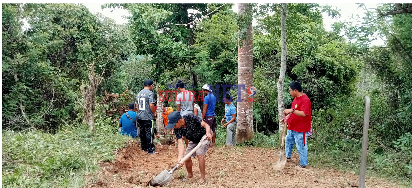
Warga saat bergotong royong membuat jalan masuk material
