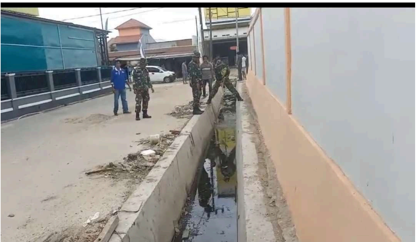
Kondisi Saluran air setelah dibersihkan
