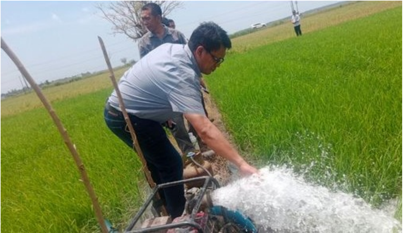
Uji coba pompa air
