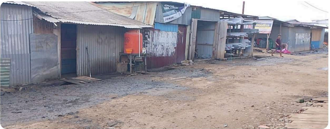
Kondisi Pasar Sebelum dan sesudah dibersihkan
