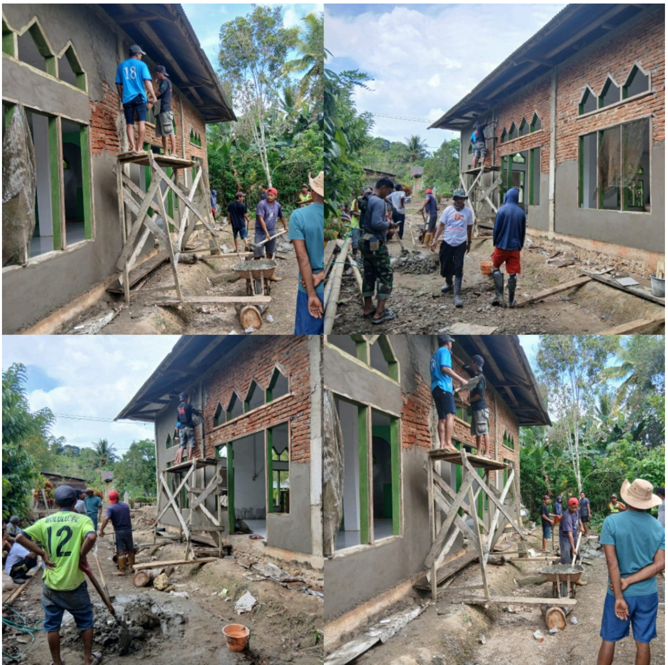
Satgas TMMMD ke-124, Lanjutkan Pengerjaan Rehap Masjid Al-Mujahidin Desa Morengke
